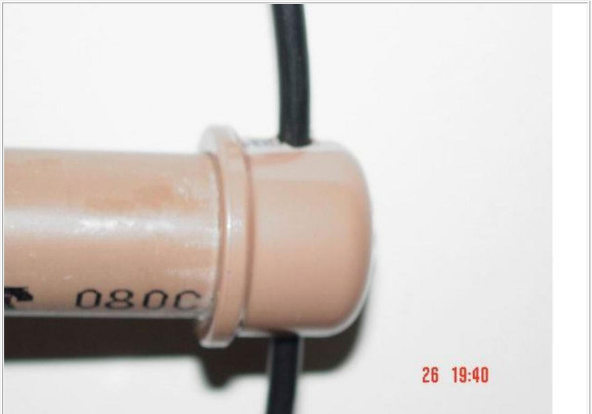
**Detalhe do cabo coaxial passando na terminação do tubo.**
