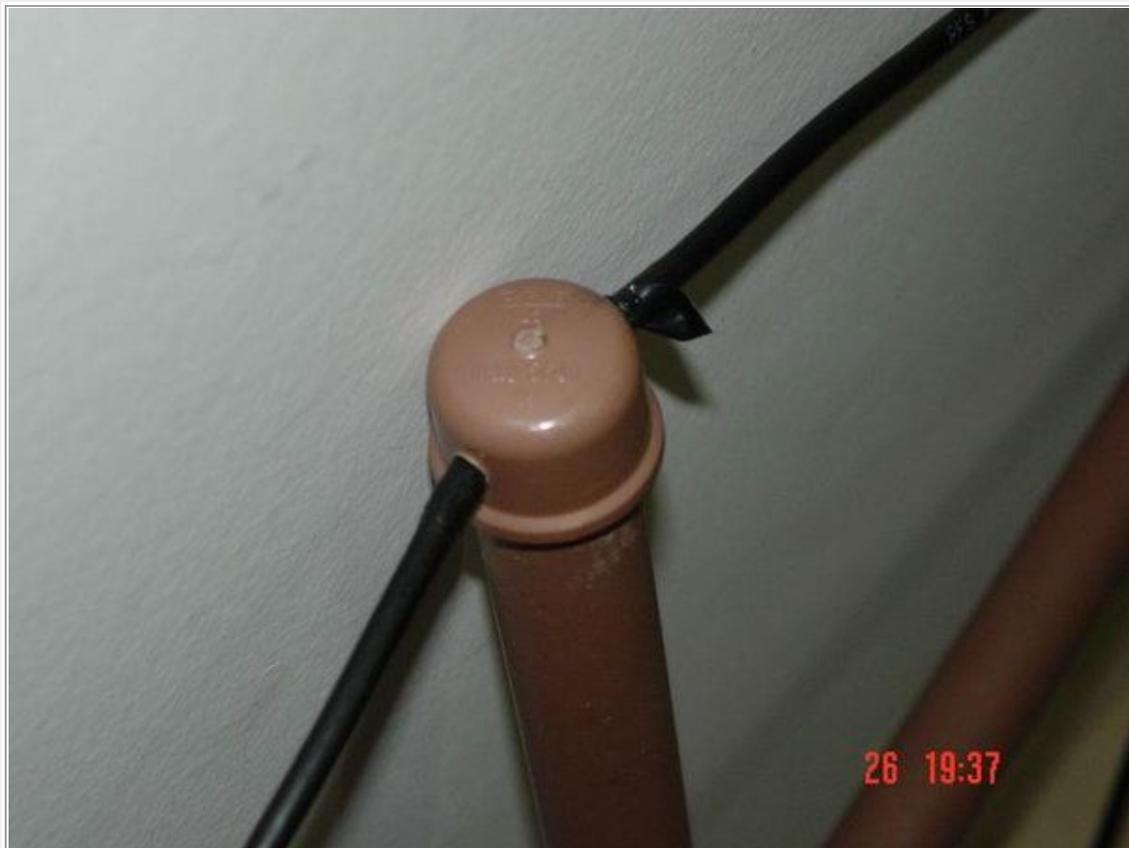
**Detalhe do "gap" de 5 cm no cabo coaxial, recoberto com fita isolante para reforço.**
