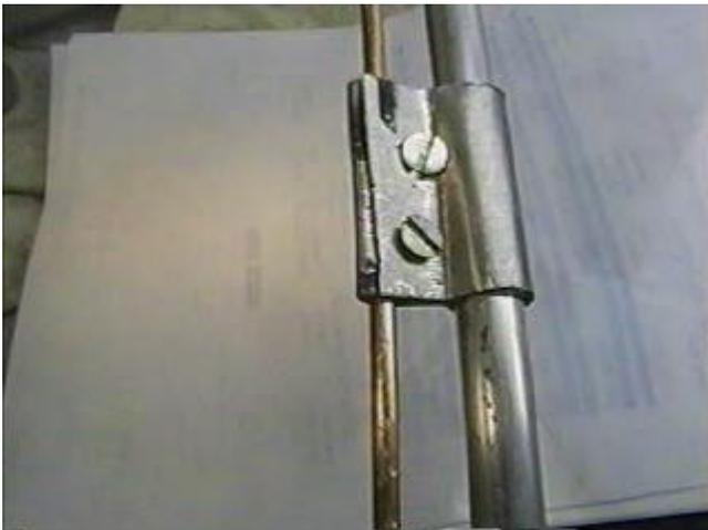
Aspecto após regulagem e fixação com parafusos.
