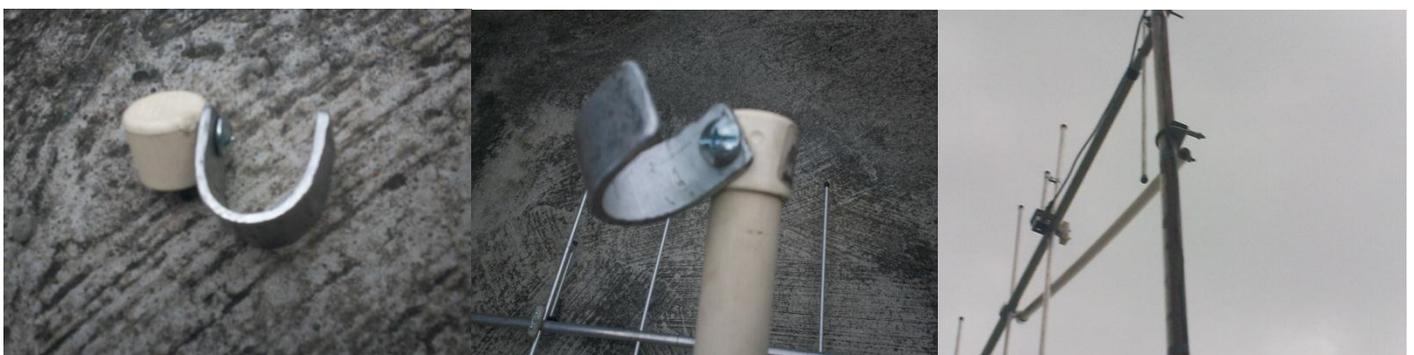
A continuación se indican cálculos típicos para antena Yagi 7 de elementos, ideal para usos en frecuencias VHF similares. **Inicialmente se calcula la longitud del elemento Driven ( L1 ),** el cual servirá de referencia para el resto de longitudes, donde 142.5 representa una constante para cálculos de longitudes en antenas Dipolos de  $1/2\lambda$ , “ F ” será la frecuencia de trabajo ( En Megahertz = MHz ) y el resultado será en metros.
