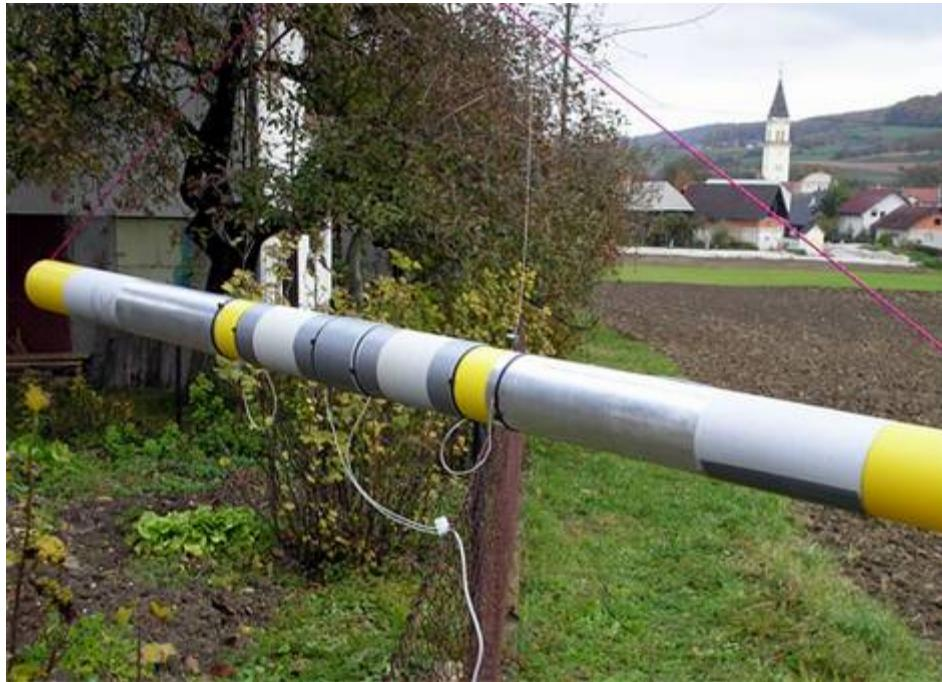
9A4ZZ Bipol antene za 160m in 80m dvigujem na osem metrov višine. Merim SWR, uglašujem. Postavitev anten bo prvo noč horizontalna, naslednjo noč vertikalna. Snamem antene in jih spravim v garažo. V petek dopoldne antene pakiram v bele pvc vreče, lepim, vežem, poskušam jih čim bolj zaščititi od dežja.
