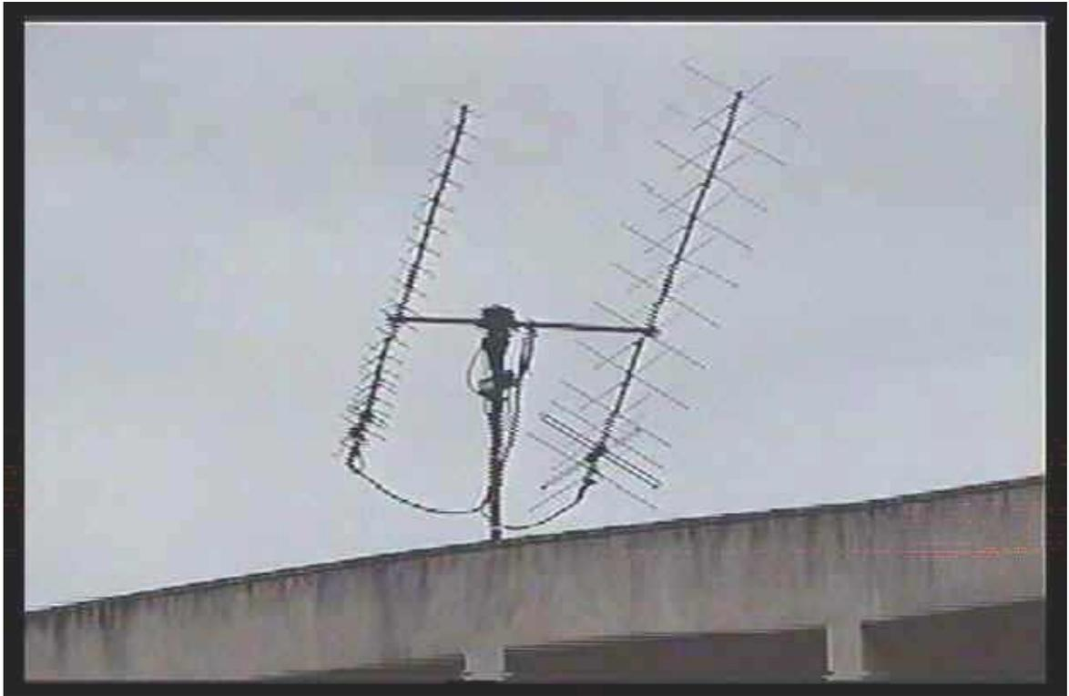
**Ilustração 21** – Antenas de VHF e UHF cruzadas faseadas em polarização axial direita para satélite. Com rotor azimutal e elevação.
