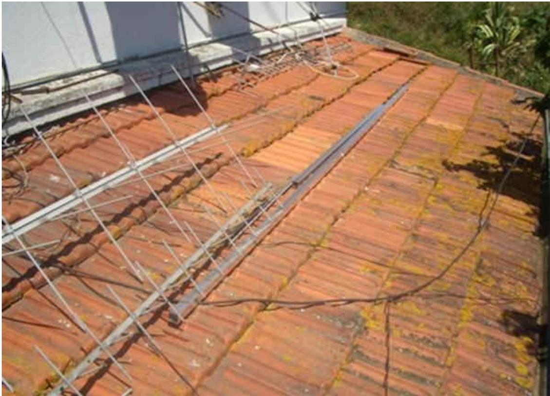
**Ilustração 17** – Tubo alumínio secção quadrada para o bum dos dipolos de 40 e 80 mts.
