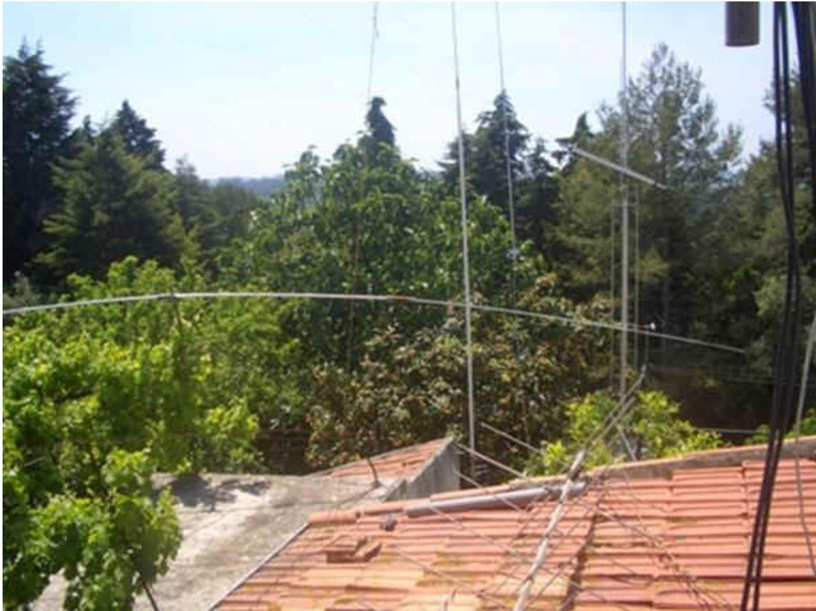
Antena dipolo rígido de 80mts em fase de experiência a 1mts do terraço que se vê na horizontal
