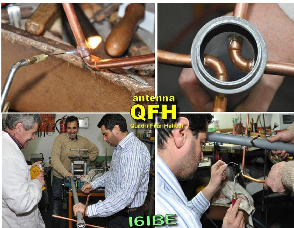
Materiale è il tubetto di rame da 10 mm, per le curvature superiori, inferiori e centrali, occorrono 10 curve a 90 gradi di rame. Una volta tagliati al millimetro gli spezzoni in rame, verranno inserite nelle curve dopo averli preventivamente curvati e lucidati con carta abrasiva finissima le
